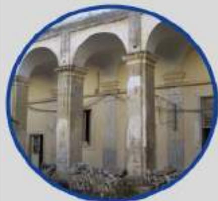
DIAGNOSTICA SU STRUTTURE ESISTENTI
